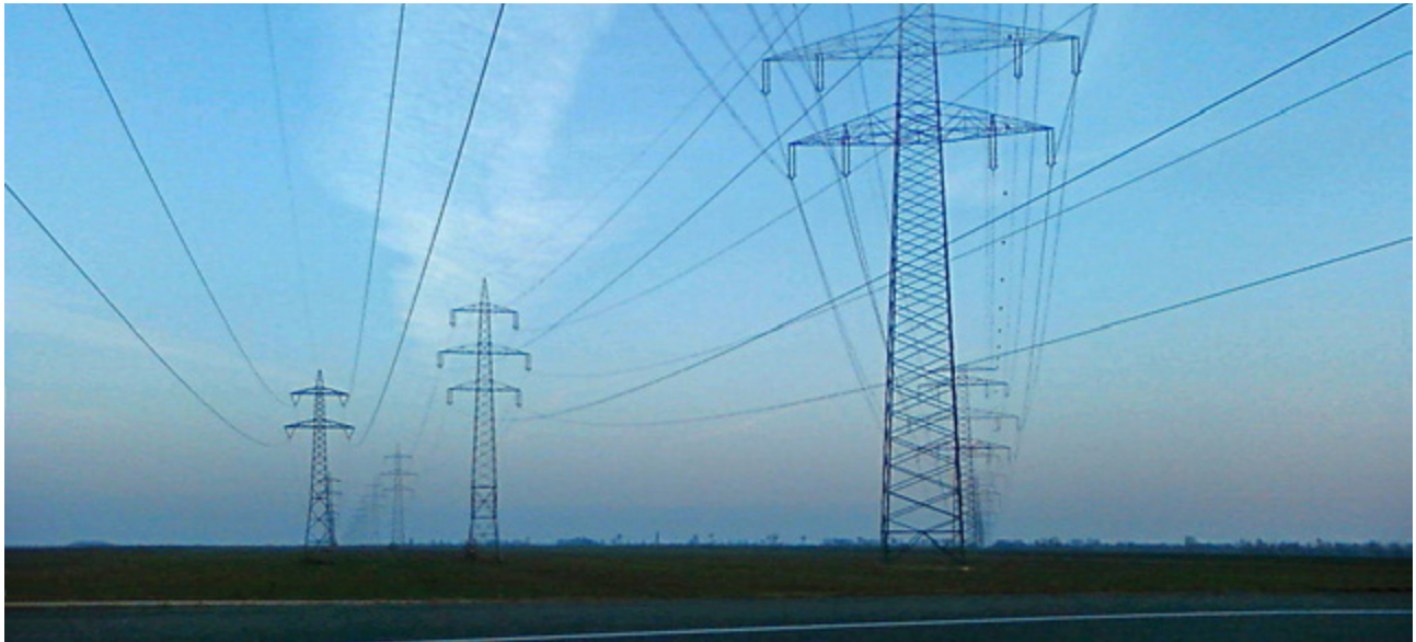
Strommasten in Himberg. Das Stromnetz fällt unter kritische Infrastruktur. Sein Ausfall kann fatale Folgen haben. FOTO: M.DUFEK, CC BY-SA 3.0
